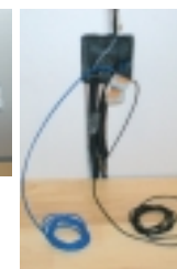
Leitungen abisolieren und in die Quick-Verbinder stecken (blau zu blau, schwarz zu schwarz). Quick-Verbinder schließen, so werden alle Matten parallel miteinander verbunden.
