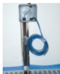
Sämtliche Anschlussleitungen werden in die Anschlussdose (Bestandteil des Regelsets) geführt.
